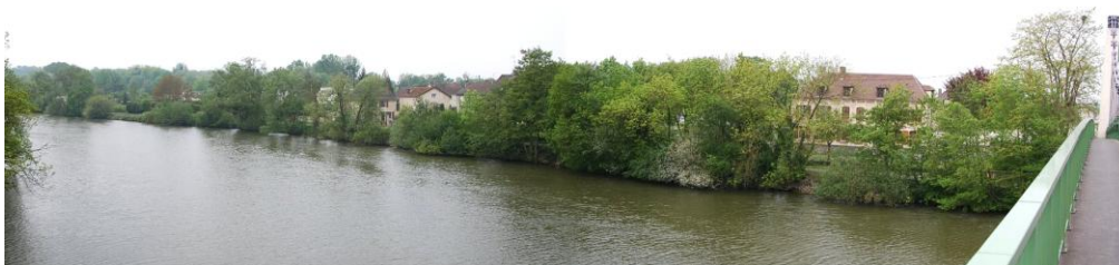
Section « verte » en aval
