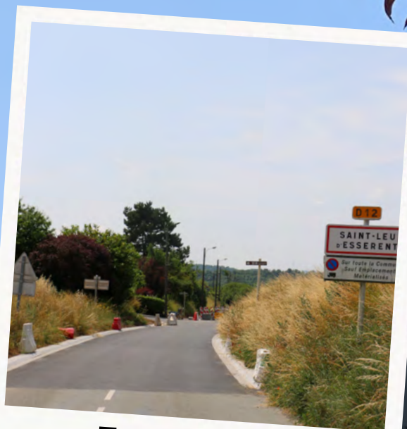
Travaux de la rue d'Hardillière
